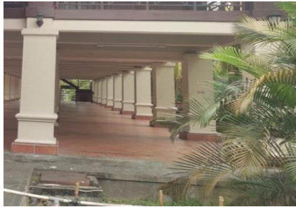
Gambar 4.2 Pilar pada rumah adat Dulohupa Sumber: Peneliti, 2022
